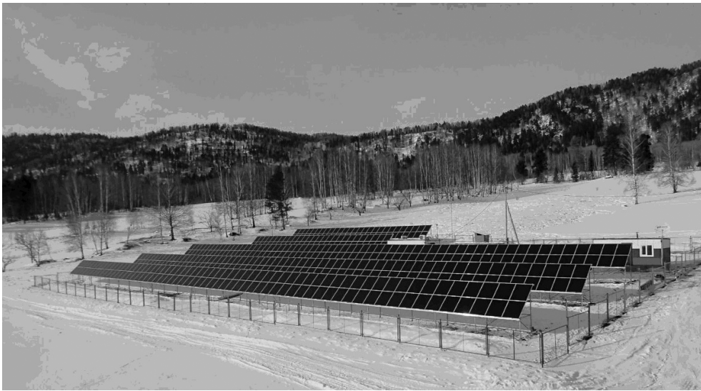
Рис. 5. Автономная солнечная электростанция мощностью 100 кВт (с. Яйлю, Республика Алтай)
