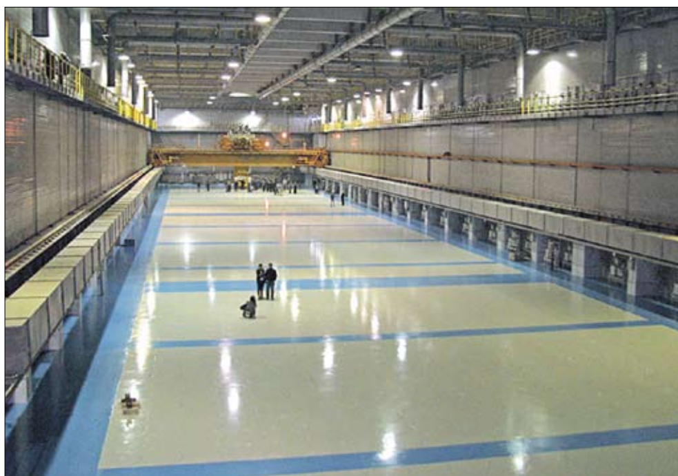
В гигантском зале хранения 2420 гнезд для размещения радиоактивных отходов.
