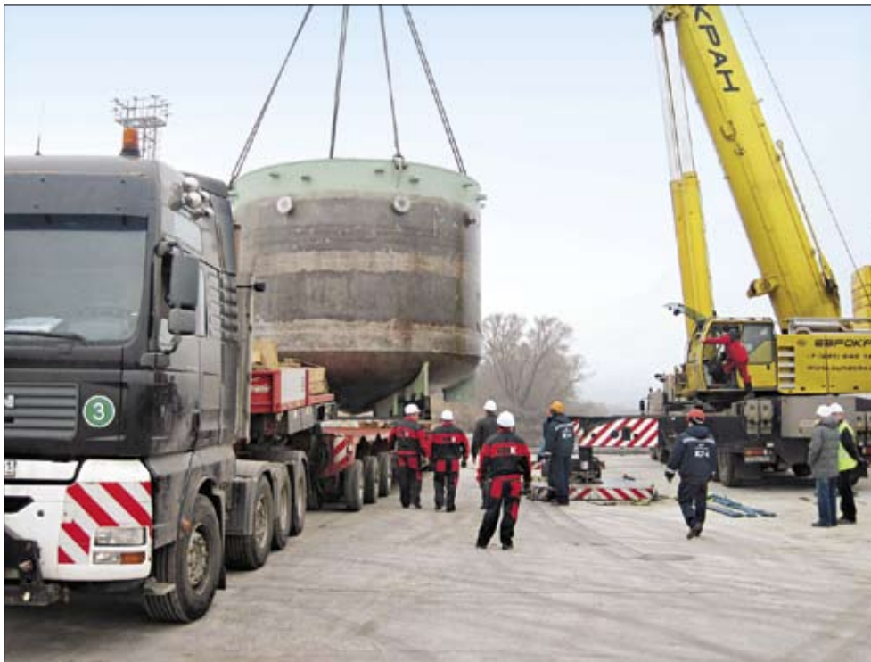
Ловушку расплава транспортируют на строительную площадку Нововоронежской АЭС. 2010 г.
