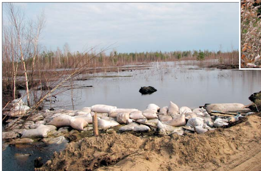
Обводнение достигается задержанием талого и дождевого стока: сооружаются дамбы и перемычки на каналах, плотины из мешков с торфом. Фото А. Возбранной и А. Сирина
