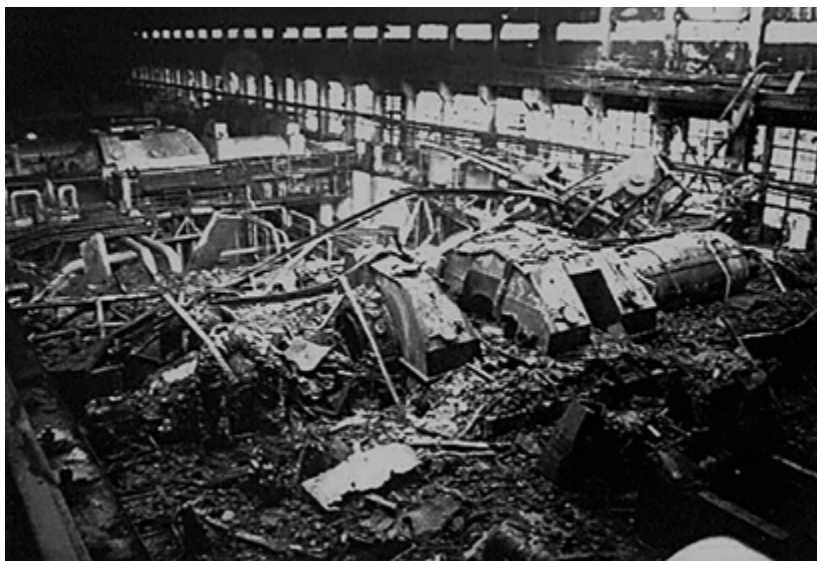
Рис. 1. Последствия аварии на энергоблоке 300 МВт Каширской ГРЭС 2002 г. (фото из статьи [1])
